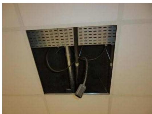
Figura 12: Derivação para luminárias (prensa-cabo e plugue)
