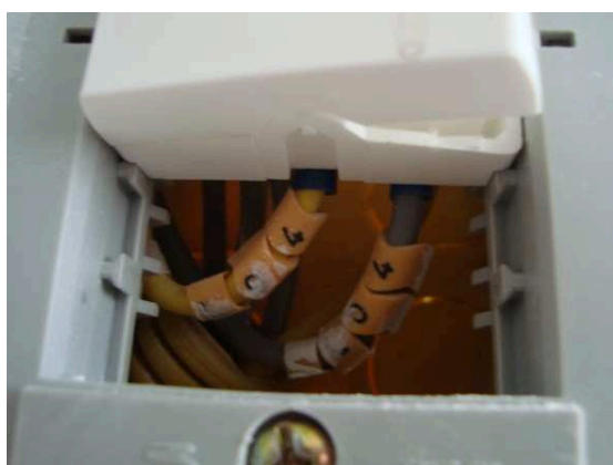
Figura 4: Identificação de condutores, tomadas e interruptores
