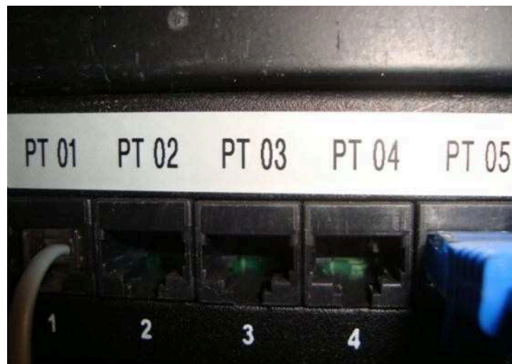
Figura 15: Patch panel com identificação de pontos
