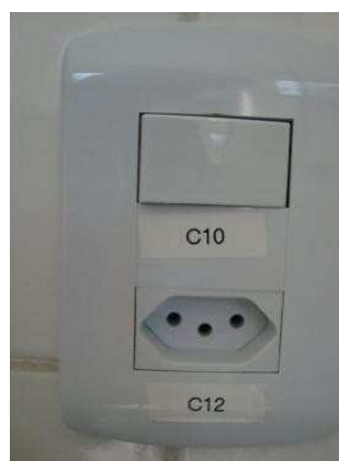
Figura 4: Identificação de condutores, tomadas e interruptores
