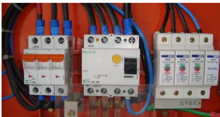
Figura 3: Disjuntor, dispositivo DR e DPS em quadro
