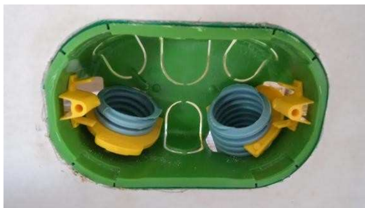
Figura 1: Caixa de ligação em drywall
