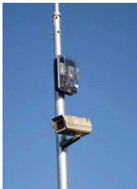
Figura 14: Infraestrutura para tomada externa de CFTV
