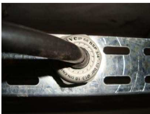
Figura 12: Derivação para luminárias (prensa-cabo e plugue)
