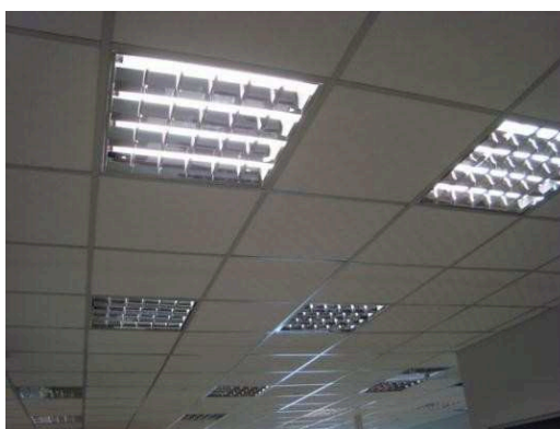
Figura 8: Luminárias embutidas em forro modular
