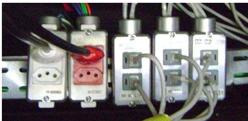
Figura 6: Padrão genérico (tomadas sobre o forro)
